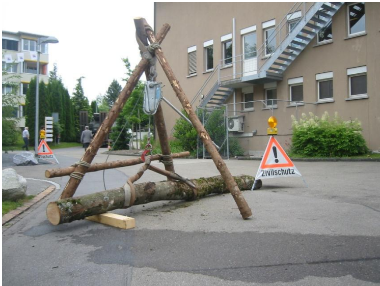
Heben einer Last mittels Dreibein
